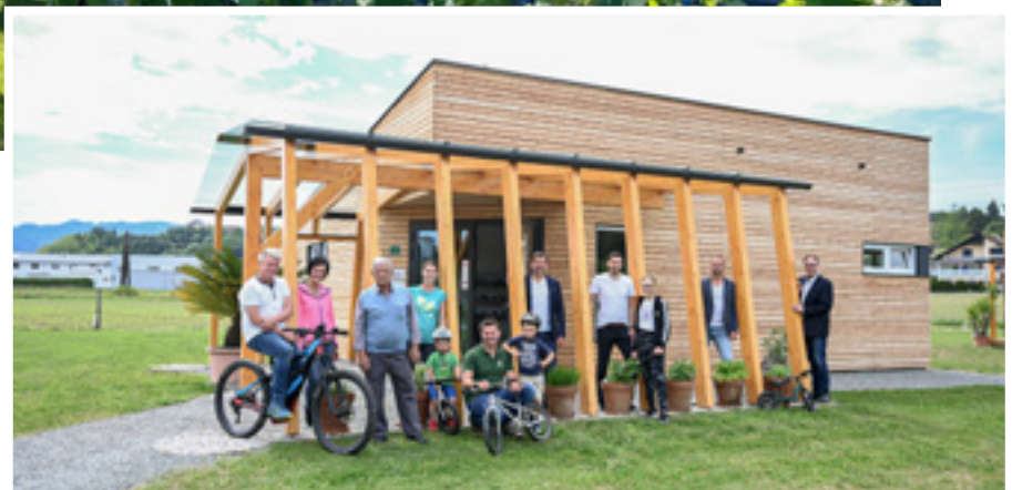
Das neu errichtete Sanitärgebäude am Tag der offenen Tür
