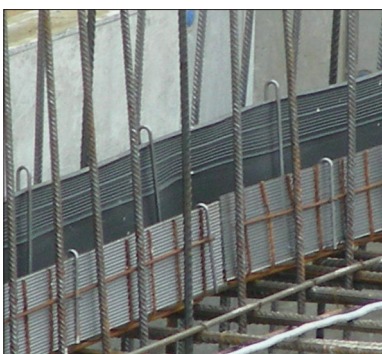
recostal® Aufkantungselement Typ 3
