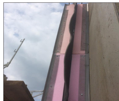
Ausführungsvariante Z3 mit entfernbarer Kunststoff-Fugenleiste
