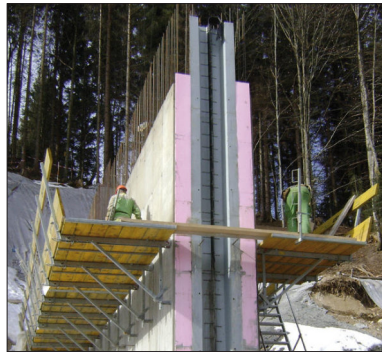
Wildbach Liezen recostal® Dehnfugenelement mit innenliegendem Dehnfugenband und Schubnocke.
