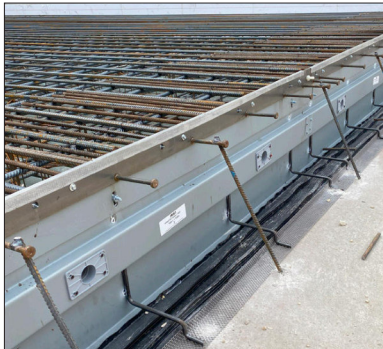
KSA Enns recostal® Keyboard XLV400, Sonder für Arbeitsfugenband außenliegend
