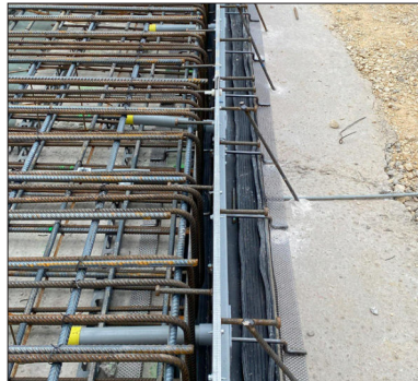
KSA Enns recostal® Keyboard XLV400, Sonder für Arbeitsfugenband außenliegend
