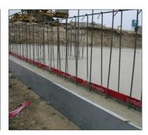
CONTAFLEX® activ sind Fugenbleche mit Bentonitbeschichtung. Das System vereinigt die Vorteile einer traditionellen Sperrdichtung mit der zusätzlichen hochabdichtenden Quellwirkung des natürlichen Natriumbentonits. Die Stoßausbildung erfolgt als Aktivstoß. Die vollflächige Bentonitbeschichtung dichtet die Fuge unüberwindbar ab. Gegen vorzeitiges Quellen ist die Bentonitbeschichtung durch eine selbstauflösende condoma-Schutzfolie gegen Regen und Nässe geschützt.
