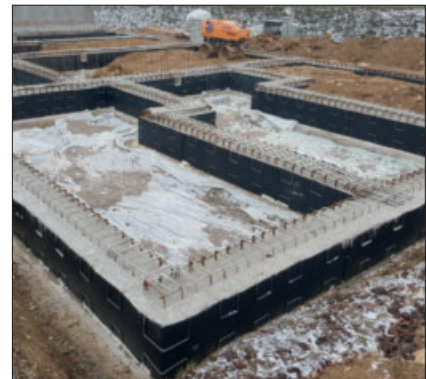
Streifenfundament selbsttragend mit Bügelsystem
