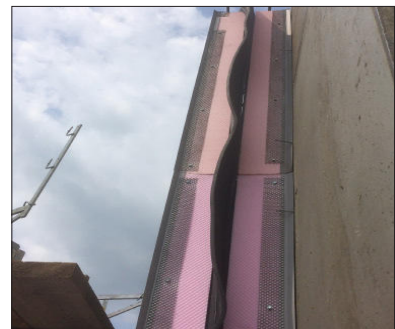
Ausführungsvariante Z3 mit entfernbarer Kunststoff-Fugenleiste
