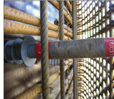
Activstop sind Distanzrohre mit zusätzlicher Bentonitbeschichtung. Das System vereinigt das traditionelle Prinzip der Umlaufwegverlängerung (Labyrinthscheiben) mit der zusätzlichen Sicherheit von 10 cm hochquellfähigem Natrium-Bentonit. Gegen vorzeitiges Quellen ist die Bentonitbeschichtung durch eine selbstauflösende Schutzfolie gesichert. Activstop Distanzrohre werden inkl. je 2 Dichtstopfen geliefert.
