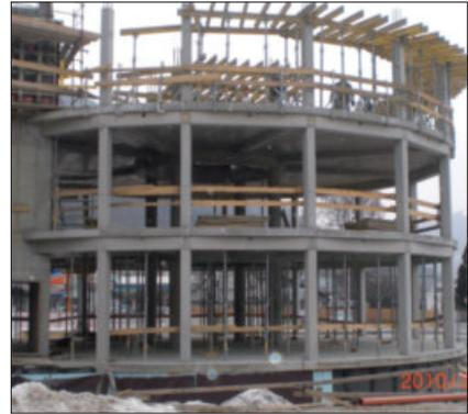
Die RELTEC Schalrohre werden aus einer recycelten, wasserbeständigen Kunststoffolie hergestellt. Die Folie ist wasserfest und kann bei jeder Witterung verarbeitet werden. Das geringe Gewicht der Schalrohre ermöglicht eine leichte Handhabung und ein schnelles Ausschalen.
