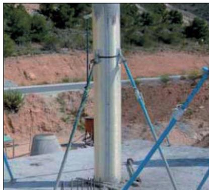
2. Deckenseitig mit Spanngurt und bauseitig vorhandenen zug- und druckfesten Richtstützen lotrecht einrichten und gegen Auftrieb sichern.
