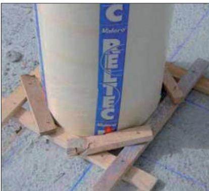
1. RELTEC Schalrohre fundamentseitig in die Achse stellen. (mit Holzkern fixieren).
