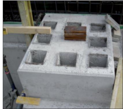
Für die Verankerung von Maschinen sind auf kleinstem Raum oft eine Vielzahl von Verankerungskörpern anzuordnen. Durch die Herstellung von Aussparungsgruppen wird der Einbau und das Einmessen der Aussparungen wesentlich vereinfacht.
