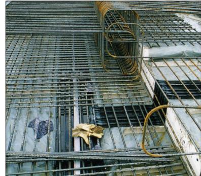
Der Einsatz von Fugenbändern aus PVC gehört zu den traditionellen Methoden der Fugenabdichtung. Unterschieden wird in erster Linie nach abzudichtender Fugenart (Dehnungs- und Arbeitsfugenbänder) und in zweiter Linie nach der Lage des Bandes im Bauteil (außen- bzw. innenliegend). Außerdem stehen noch verschiedene Ausführungsarten (stahlarmiert, leichte Ausführung / Standardausführung) zur Verfügung.
