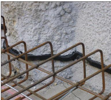
1. Quellband mittig in der Fuge verlegen, jedoch mit mind. 8 cm Betonüberdeckung.
