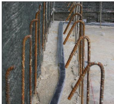
2. Mitgeliefertes Befestigungsgitter auf das Quellband legen, bei Quellbändern mit Schutzhülle diese nicht abziehen.
