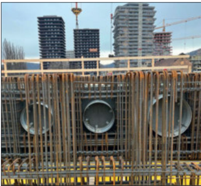
Runde Aussparungen aus Glattblech wiederverwendbar, Ø bis 73cm
