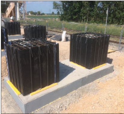
Detail ES -Schalung selbsttragend
