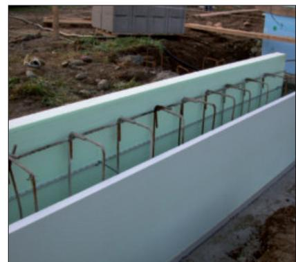
Für Schalhöhen von 20 cm bis 25 cm Montageklammer verwenden.
