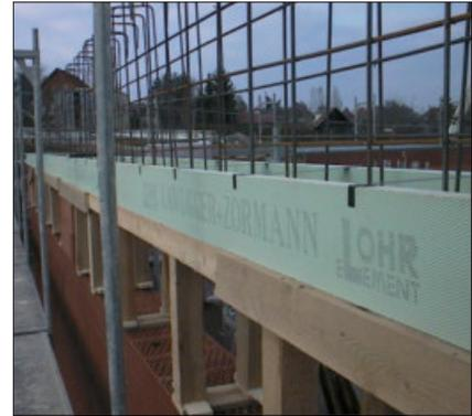
Die LZB-Mauerrostsysteme sind Systeme zur einfachen und schnellen Abschaltung von Mauerrosten. Sie sind Kombinationen der LZB-Deckenrandschalungen. Es können sowohl verschiedene Materialien (XPS, Holzbeton), als auch verschiedene Höhen kombiniert werden (z.B. Deckenrand inkl. Abschaltung für die nachfolgende Decke). Zur Befestigung auf der Mauerkrone dient ein spezieller Schaum auf PU-Basis.
