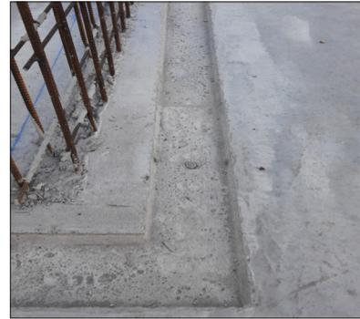
Wiederverwendbare Negativschalung aus Glattblech in konischer Ausführung inkl. Stoßlaschen zur Herstellung einer Ablaufrinne gegen Tauwasser. Quergefälle mittels Gewindestange bauseits herstellbar. Bohrungen gegen Aufpreis möglich. Gewindestangen und Muttern sind nicht im Lieferumfang enthalten.
