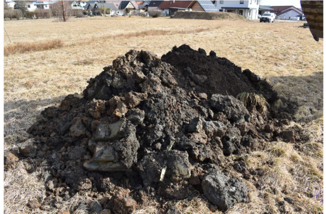
Bild 7: Schurf S3 - Aushubmaterial, Aufnahmedatum 08.03.2022
