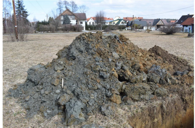
Bild 15: Schurf S7 - Aushubmaterial, Aufnahmedatum 08.03.2022
