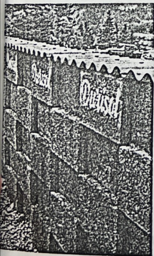
Lärmschutzwand aus DURISOL-Mantelsteinen an der A-10-Tauernautobahn
