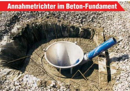
▲ Edelstahl-Trichter sorgt für sichere Entnahme.
