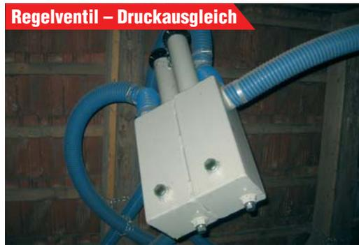
▲ Multiregler sorgt bei Temperaturschwankungen für CO<sub>2</sub>-Gas im Silo.
