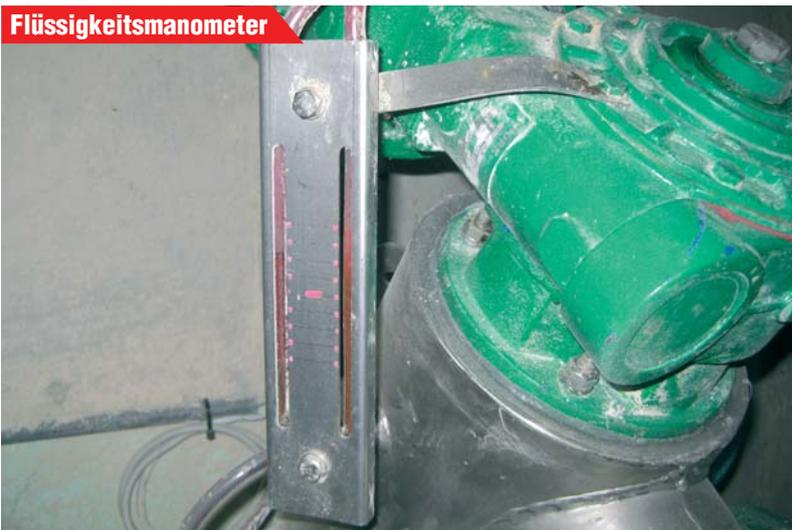
▲ Mit einem Druckmanometer kann zur Sicherheit der Gasinhalt in Millibar im Silo überwacht werden.
