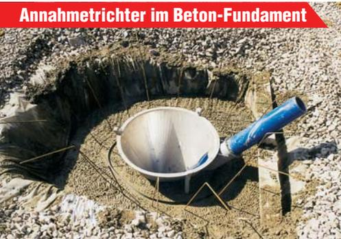
▲ Edelstahl-Trichter sorgt für sichere Entnahme.
