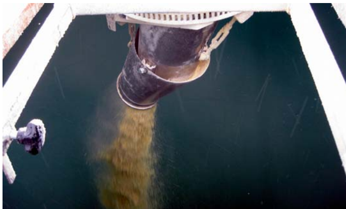
Bei kleineren Silos ohne Verlängerungsrohr.
