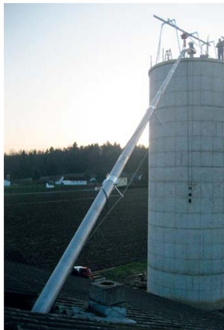
Edelstahl-Ablaufleitungen werden pfeilgerade direkt bei den Kunden geschweißt und montiert. Hier befindet sich das Absauggebläse auf der Silokrone.
